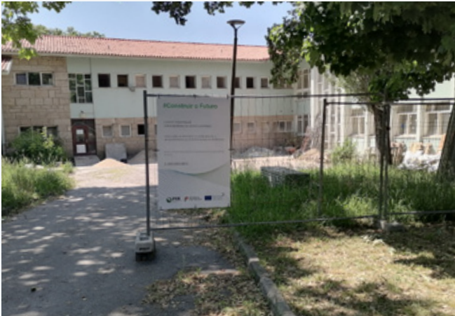
Obra de ampliação da área destinada à Psiquiatria Forense no Hospital Magalhães Lemos
