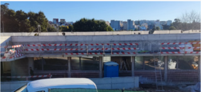
Construção da Nova Unidade de Saúde Mental de Gondomar
